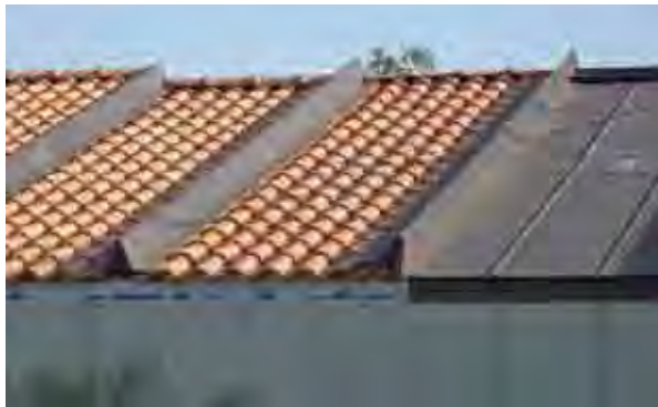
1a. Coperture in laterizio a scala reale (una ventilata e l'altra microventilata) e con manto continuo in rame.
