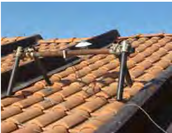
4. copertura ventilata con manto in laterizio.
