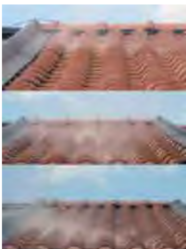
9. Test di tracciabilità del movimento d'aria nella copertura con manto in laterizio (LV6-A).
