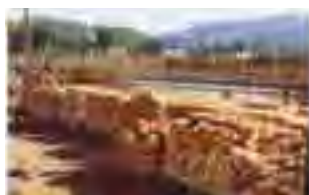
Fig 7. Complesso residenziale Taviel a Saint-Omer (F). Nel dettaglio, immagine dei mattoni recuperati e accatastati in attesa del reimpiego.
