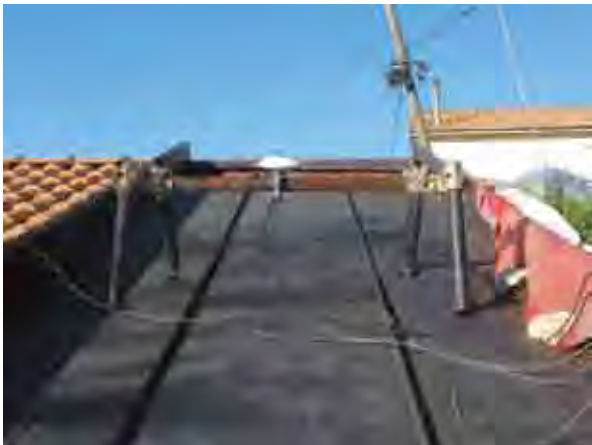
3. Copertura ventilata con manto in rame.
