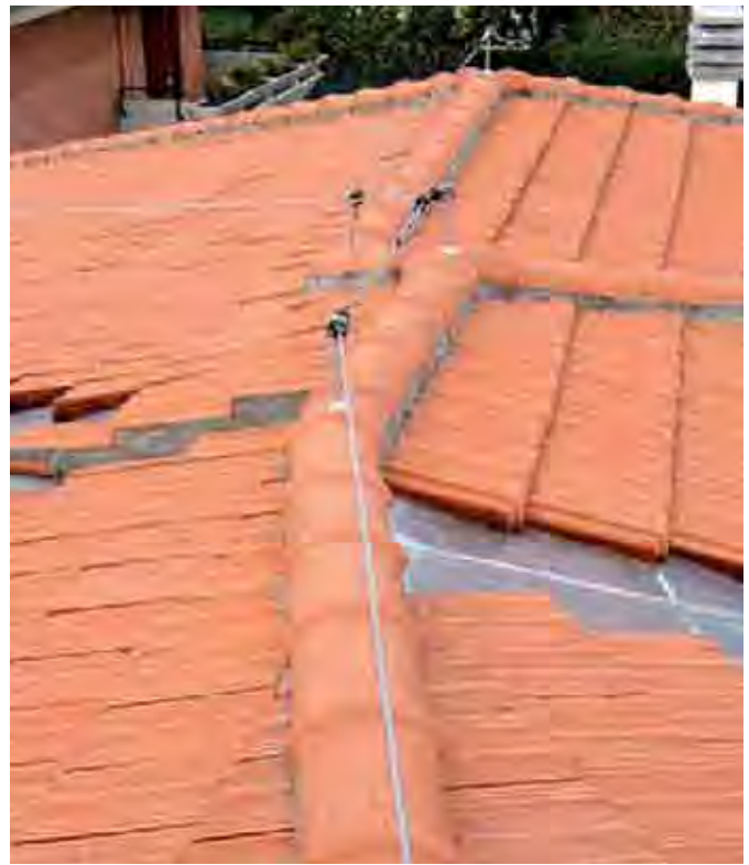
3. Esempio di dispositivo di sicurezza per l'ispezione della copertura.
