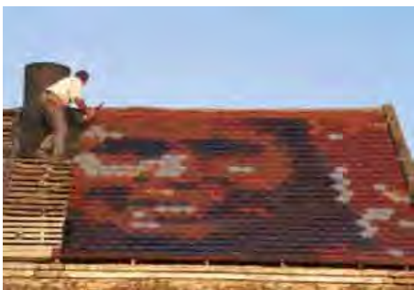
Una fase di posa in opera del manto di copertura.
