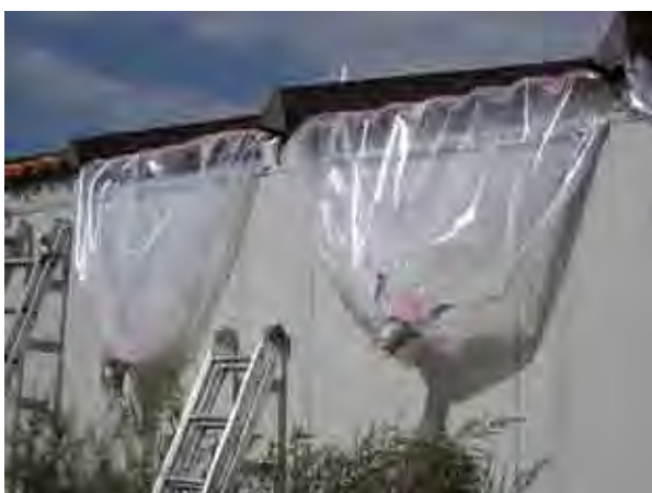
2. Dispositivo per il rilievo qualitativo della permeabilità del manto.
