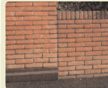
GIUNTO DI SEPARAZIONE CORRETTAMENTE ESEGUITO
