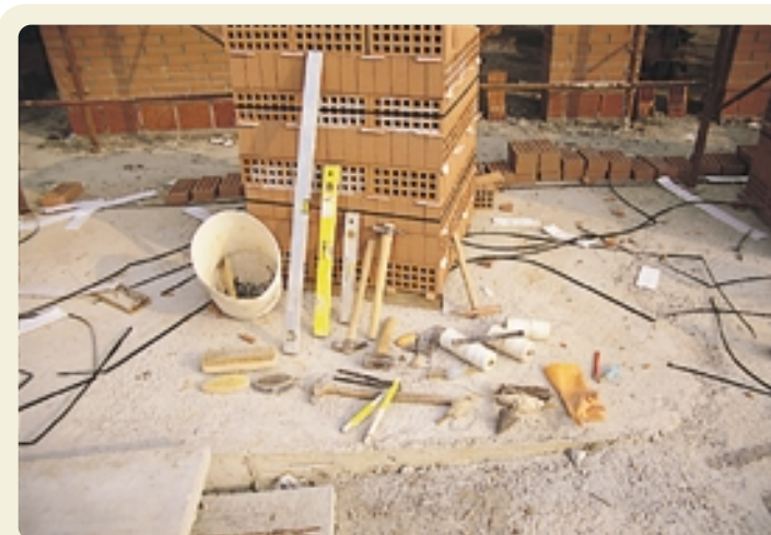
I PRINCIPALI ATTREZZI USATI DAI POSATORI
