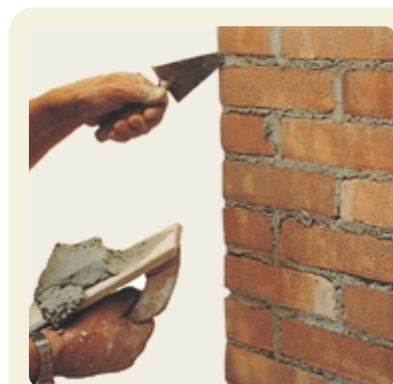
SPARVIERE PER SORREGGERE LA MALTA E CAZZUOLINO PER RIFINIRE LA MURATURA
