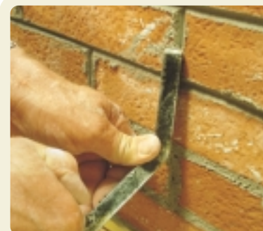
FERRO QUADRO PER LA STILATURA DEI GIUNTI AD ANGOLO O A SGUINCIO
