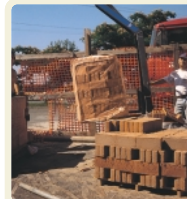
MOLTI PRODUTTORI CONSEGNAANO I PACCHI GIÀ PROTETTI CON UN INVOLUCRO IN PLASTICA TERMORETRATTILE
