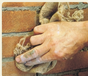
STRACCIO DI IUTA PER LA PULIZIA DELLA MURATURA FRESCA
