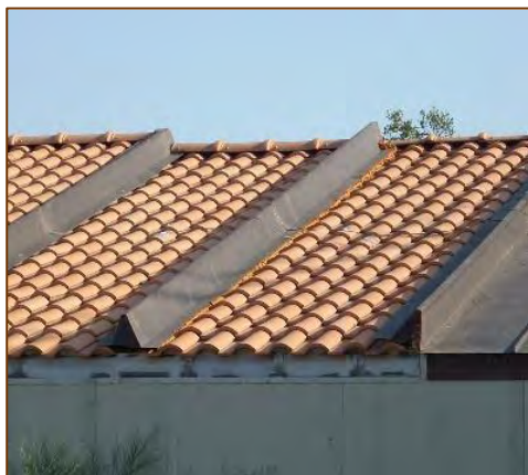
Figura 5. Falda di copertura monitorata
